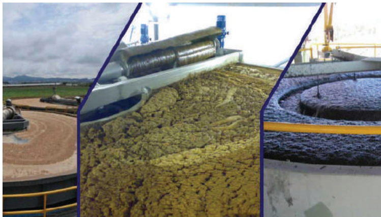
نمای کلی فرایند تصفیه پساب با استفاده از روش شناورسازی هوای محلول
